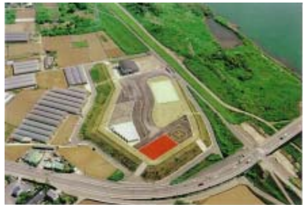
写真 - 6 防災ステーション空撮
