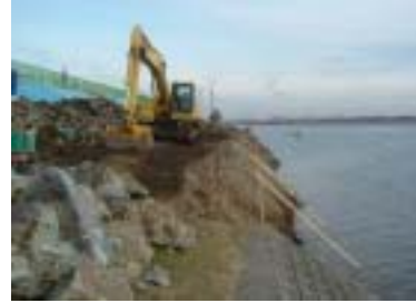
写真-10 工事現場の状況(1月中旬)
