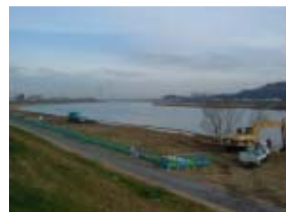
写真-7 工事現場の状況(1月中旬)
