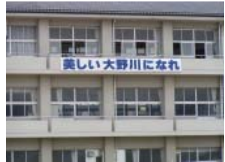
写真-1 東陽中学校の看板
