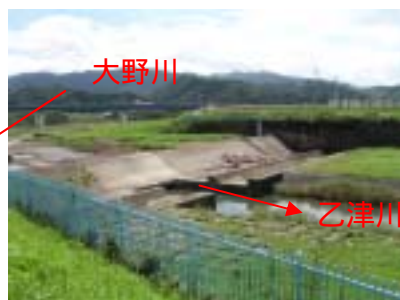
写真-11 乙津川分流堰
