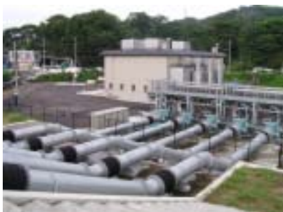
写真-12 迫排水機場の全景
