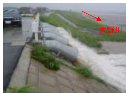
写真-13 排水状況
