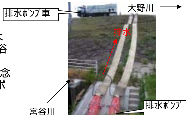
写真-3 排水ポンプ車出動状況(宮谷川)
